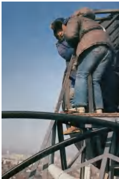
施工人员在调整安装天馈线
